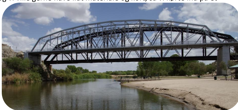
Yuma Bridge fra 1915 over Coloradofloden
